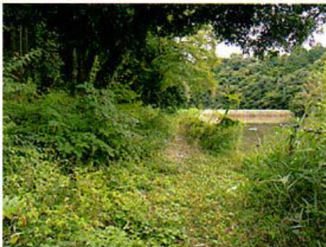
水戸市常照寺池（1）
