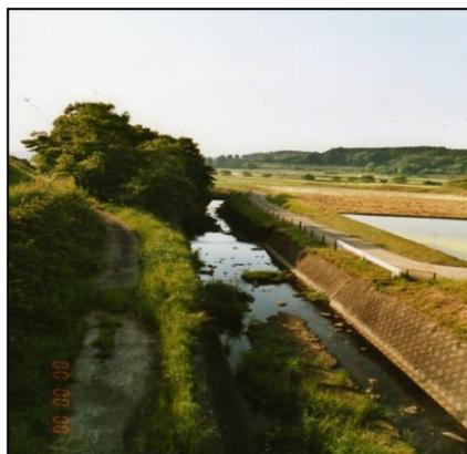
4：図 3：図の方向を変えてみた流路の状況、護岸の高さは最高3mもあります。
