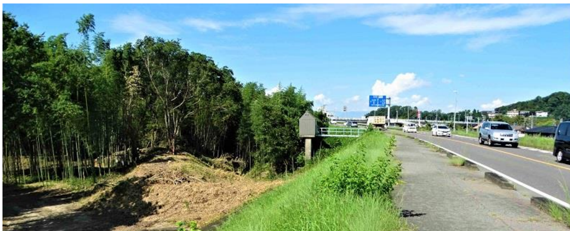
竹林内にむき出しになった「久官藪」と現在の堤防道路
