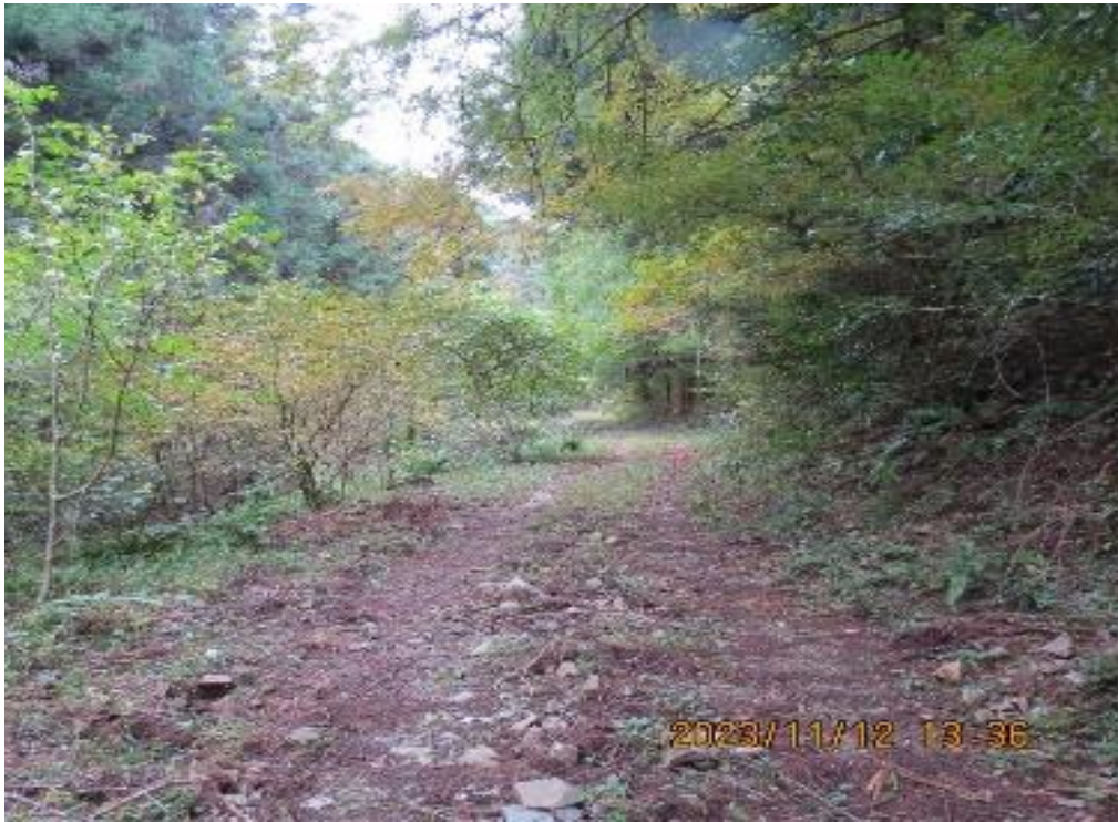
29：図 右側の樹木の先が1600m地点です。見た目には台風前と変わりませんが、台風の被害で出来た林道上の溝はここまで続いていて、1200m付近から運んだ土砂で埋め立ててあります。19号台風の災害補修工事はここ迄で終了しています。
