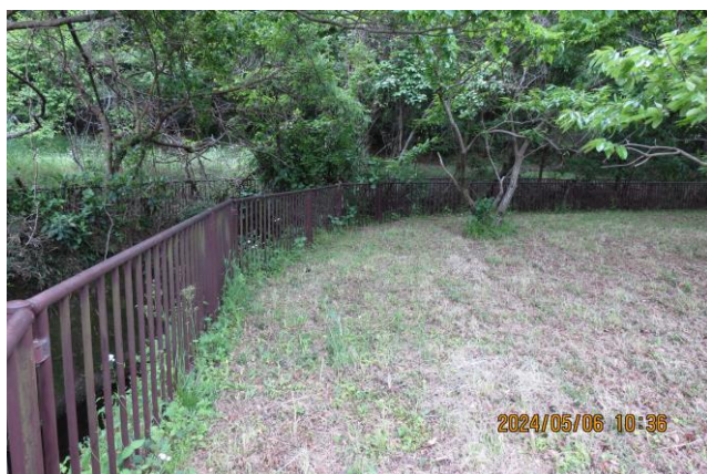
1: 図 柵の内側が水路
