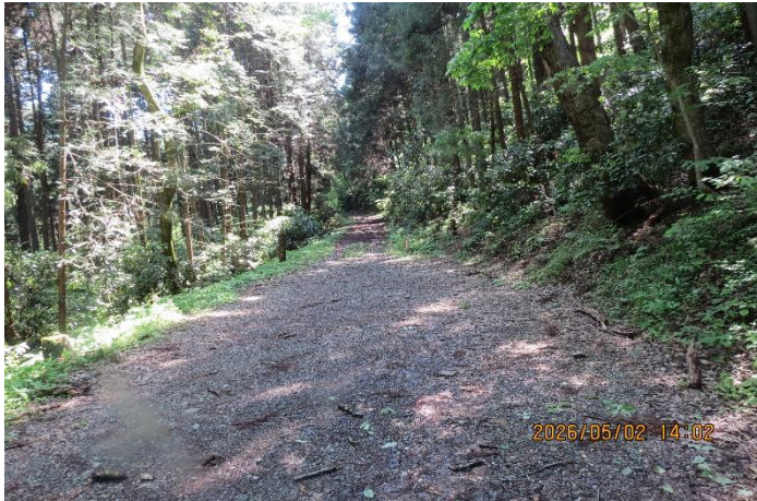
14：図 650m、地面が災害対策で舗装されています。
